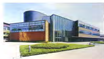
ホールの機能も有する 文学部図書館
